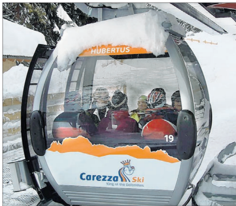
Die Kabinenbahn „Hubertus“ im Skigebiet Karersee wurde in Rekordzeit gebaut.
